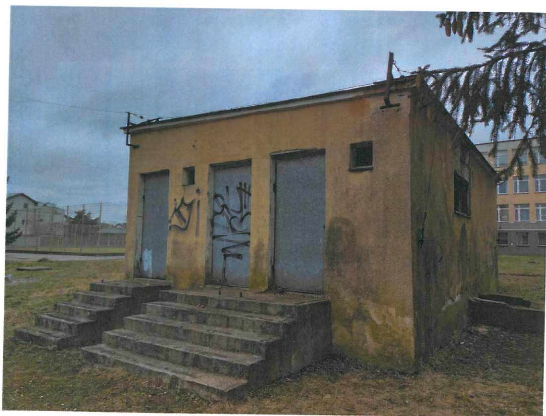
Fot. 6 – Budynek sanitariatu
