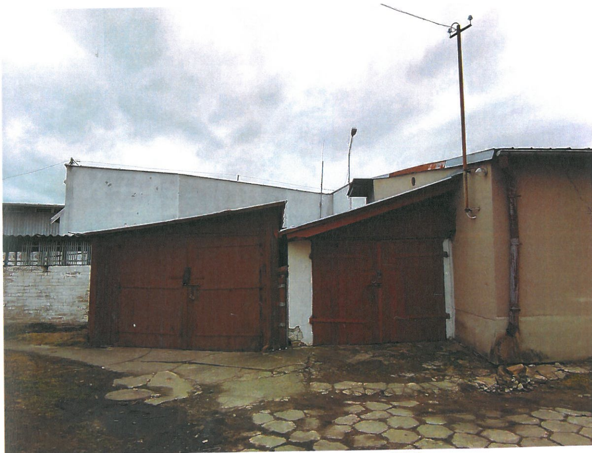
Fot. 3 - Budynek garażowy 2 i 3
