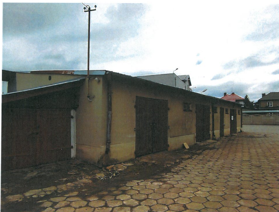
Fot. 2 - Budynek garażowy 1 i 2
