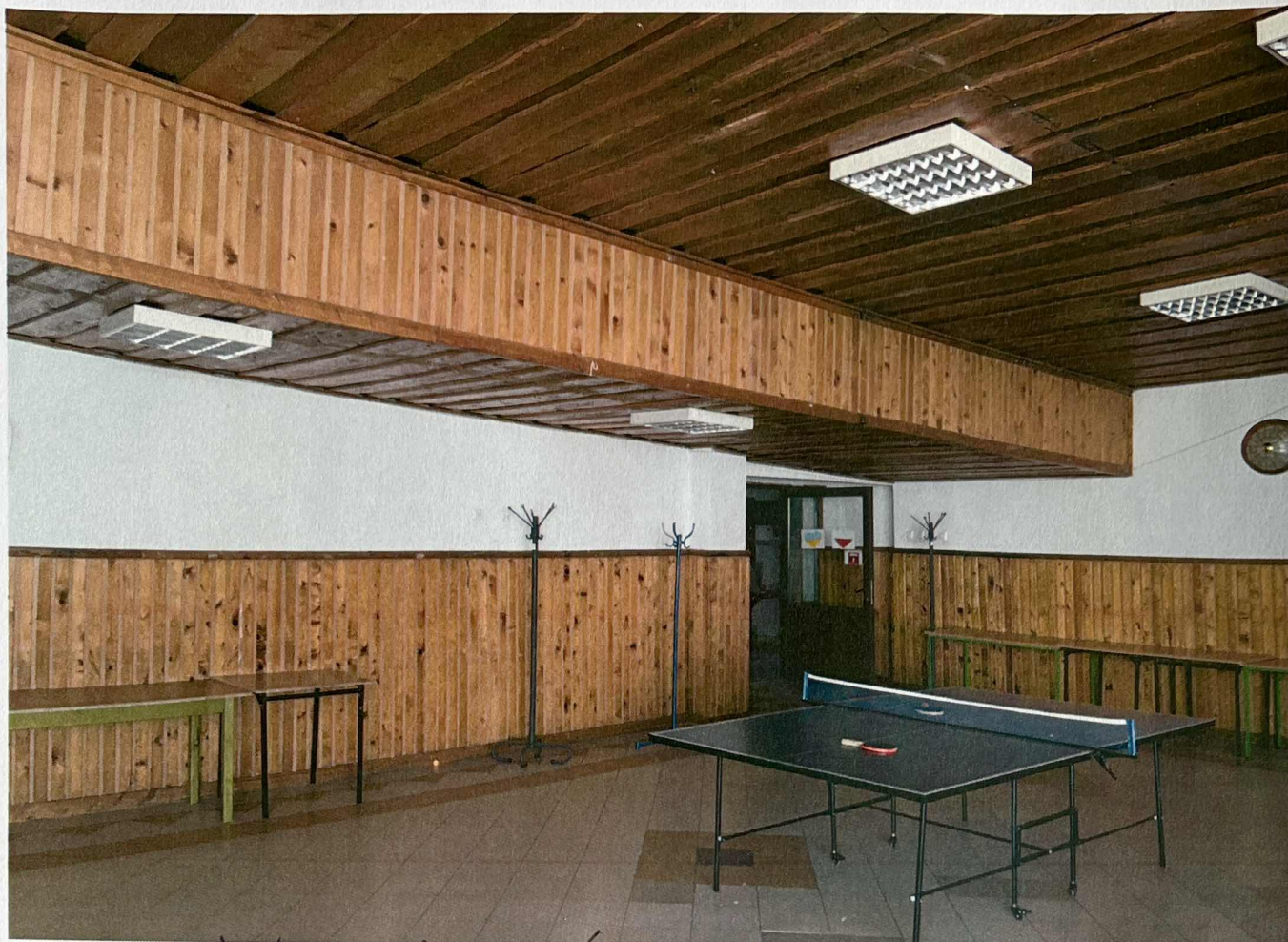
SALA WIDOK OGÓLNY / WSKAZ STROPI FOT. 1
