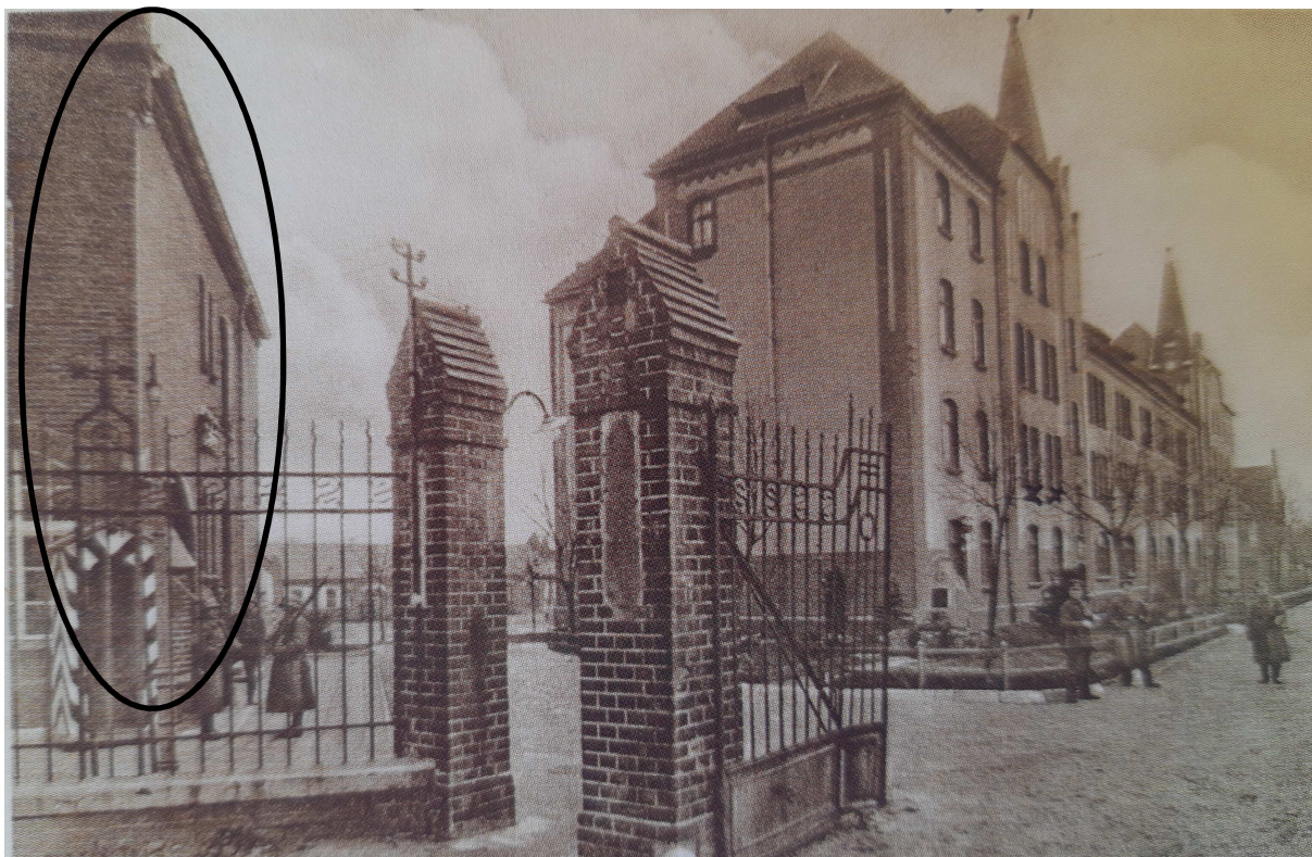
Fot 2. Pocztówka z napisem Allenstein-Langseekaserne z ok. 1920 r. Oznaczono badany budynek, widoczny narożnik elewacji północnej i wschodniej. Źródło: Rafał Bętkowski, Olsztyn jakiego nie znacie, str. 161.
