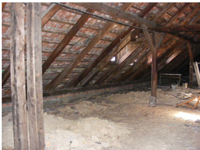
Zdj. 1 – widoczny duży rozstaw słupów
