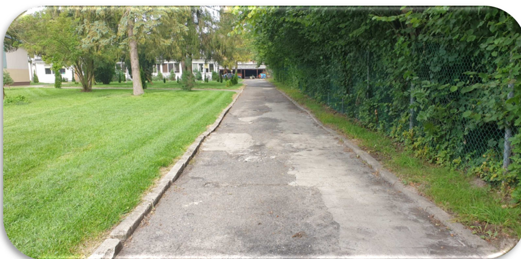
Zdjęcie nr 4. Istniejąca nawierzchnia drogi odcinek B-B.
