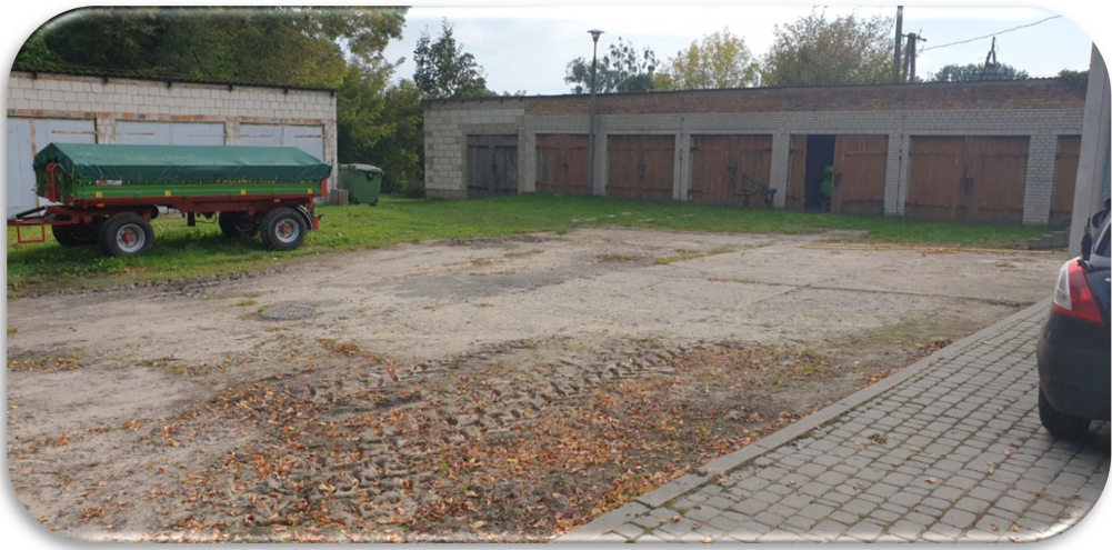
Zdjęcie nr 5. Plac przeznaczony do remontu w etapie II.
