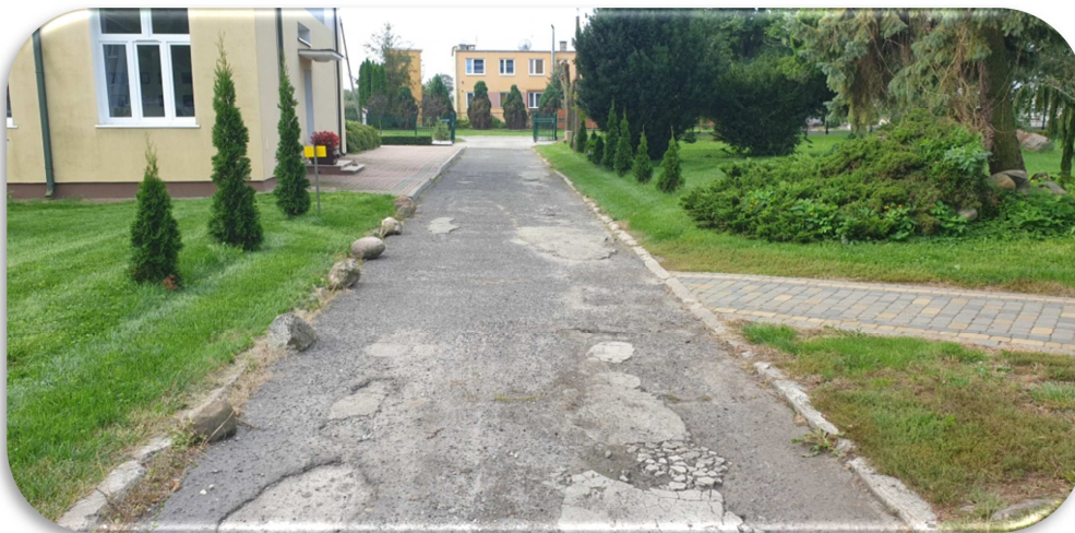
Zdjęcie nr 2. Istniejąca nawierzchnia drogi odcinek A-A.
