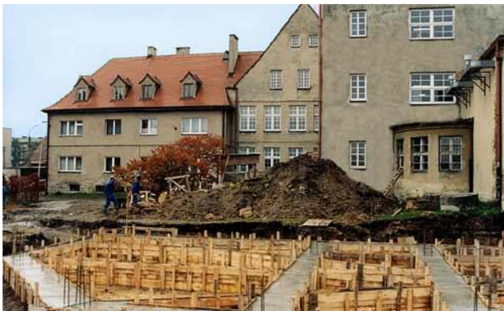
Rozbudowa szkoły w 2003 roku
