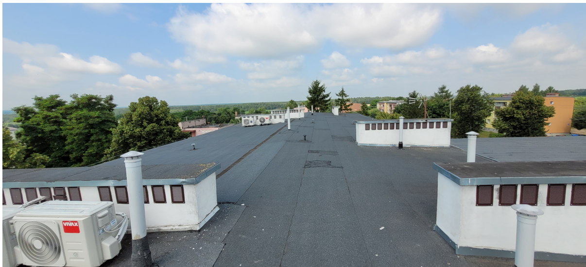
Foto 2. Północna połać dachu budynku Szkoły – Zadanie Nr 1
