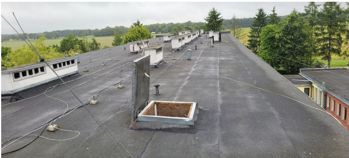
Foto 6. Wschodnia połać dachu budynku internatu – Zadanie Nr 2
