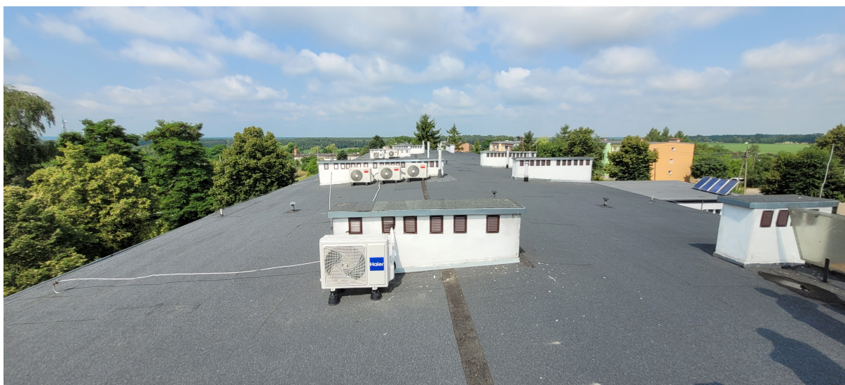
Foto 3. Południowa połać dachu budynku Szkoły – Zadanie Nr 1
