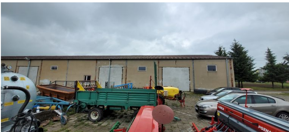
Foto 9. Południowa elewacja Budynku magazynowego – Zadanie Nr 3
