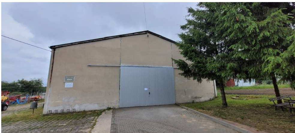
Foto 8. Wschodnia elewacja Budynku magazynowego – Zadanie Nr 3
