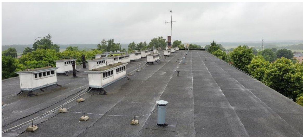
Foto5. Zachodnia połać dachu budynku internatu – Zadanie Nr 2
