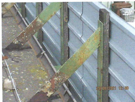
Fot.3,4,5,6. Widok istniejącej obudowy blaszanej oraz skorodowanych elementów konstrukcyjnych
