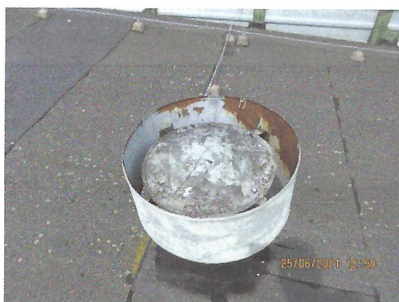
Fot.8 i 9. Wentylatory i odpowietrzenia – ślady korozji wykonać konserwację
