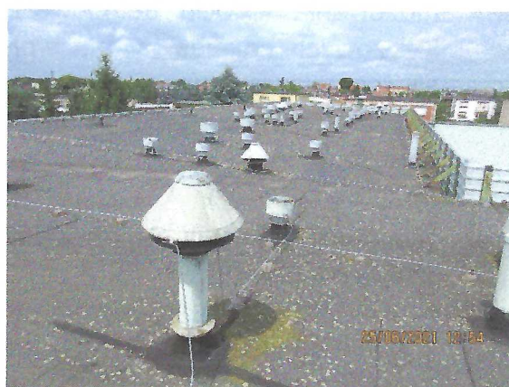
Fot.8 i 9. Wentylatory i odpowietrzenia – ślady korozji wykonać konserwację
