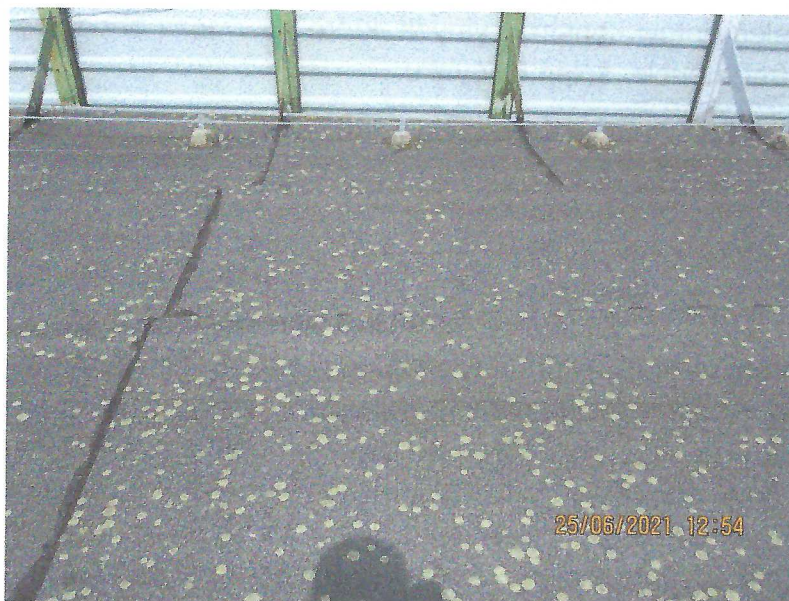
Fot. 1. Widok poszycia dachu z papy
