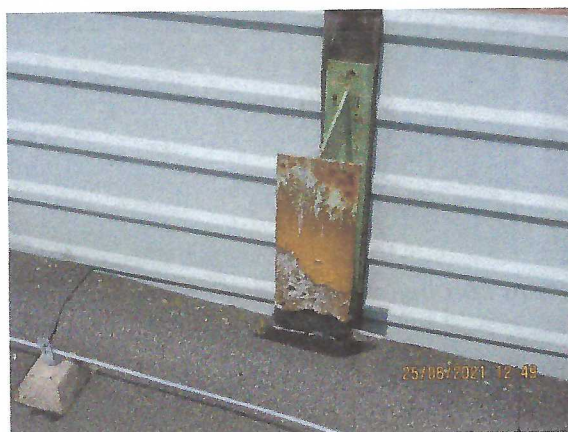
Fot.3,4,5,6. Widok istniejącej obudowy blaszanej oraz skorodowanych elementów konstrukcyjnych
