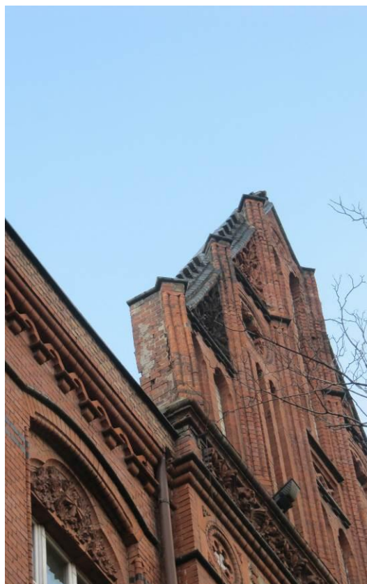
Fot. 6. Górny fragment szczytu wieńczącego ryzalit fasady; zły stan skrajnych pilastrów
