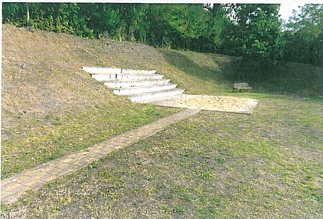
Fot. 4. Istniejąca skocznia do skoku w dal i stopnie betonowe w skarpie od wschodu – do rozbiórki
