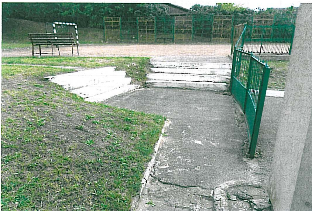
Fot. 2. Istniejące betonowe schody i nawierzchnia asfaltowa – do rozbiórki
