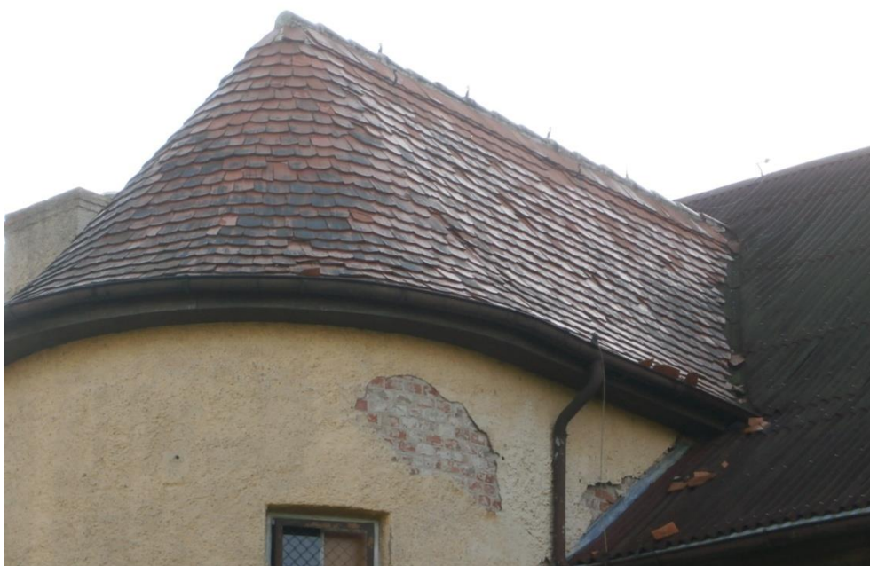
Fot.2. Widok fragmentu pokrycia z dachówki
