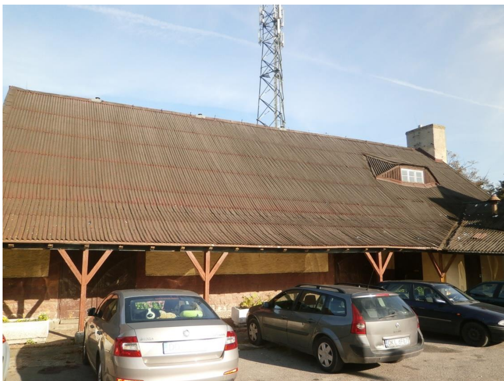
Fot.3. Widok ogólny pokrycia dachowego z podcieniami
