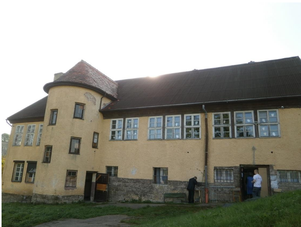
Fot.1. Widok ogólny obiektu
