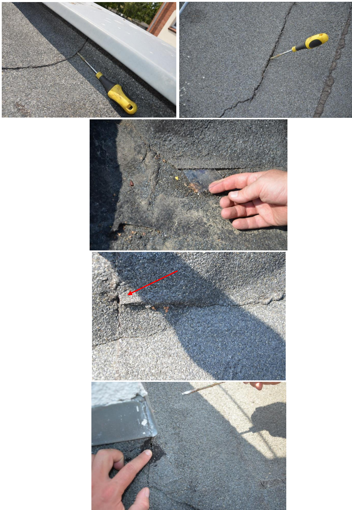
Fot.44-48. Nieszczelności w poszyciu z papy.
