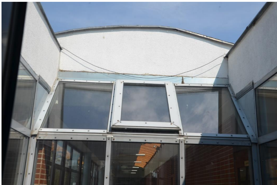
Fot.23. Korytarz po stronie południowej kompleksu – widok ogólny.
