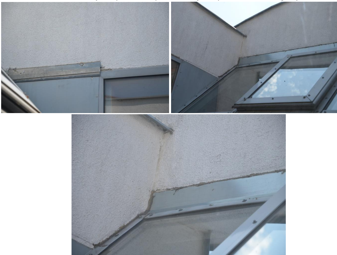
Fot.24-26. Widok uszczelniania obróbek blacharskich (korytarz po stronie południowej kompleksu).
