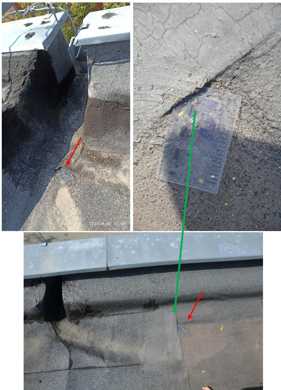
Fot.41-43. Nieszczelności poszycia z papy.
