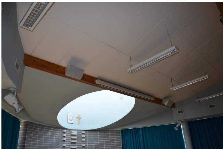
Fot.5. Sala wielofunkcyjna – sufit podwieszany
