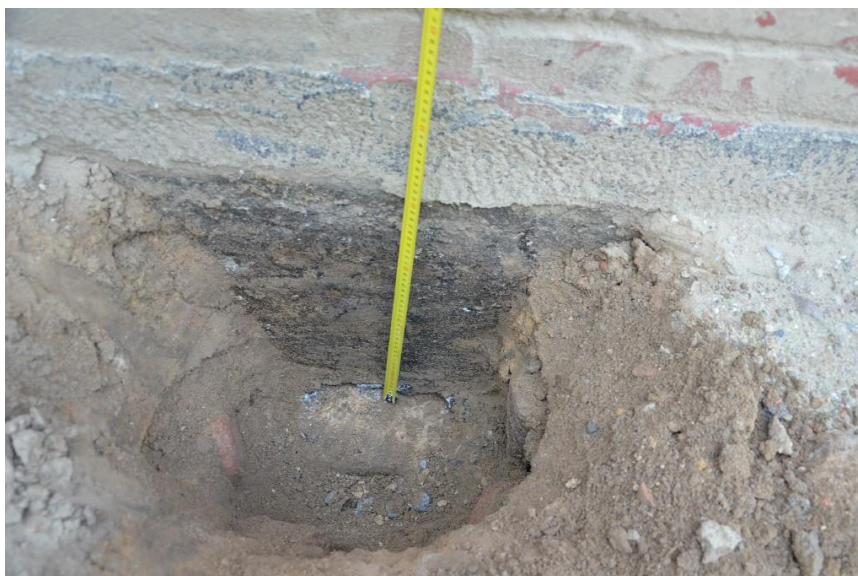
Fot.45. Odkrywka ściany zewnętrznej – widok izolacji pionowej.
