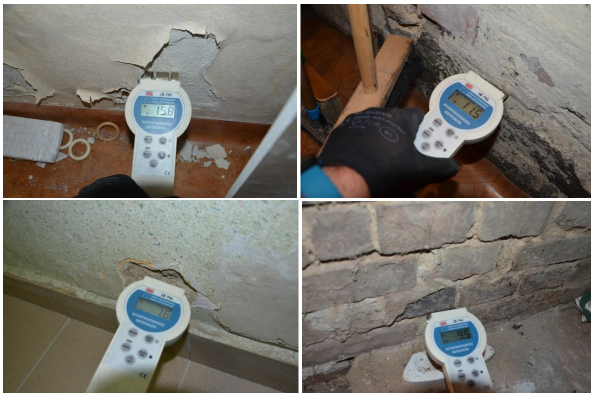
Fot. 62-65. Przykładowe pomiary zawilgocenia metodą pojemnościową w budynku nr 27.
