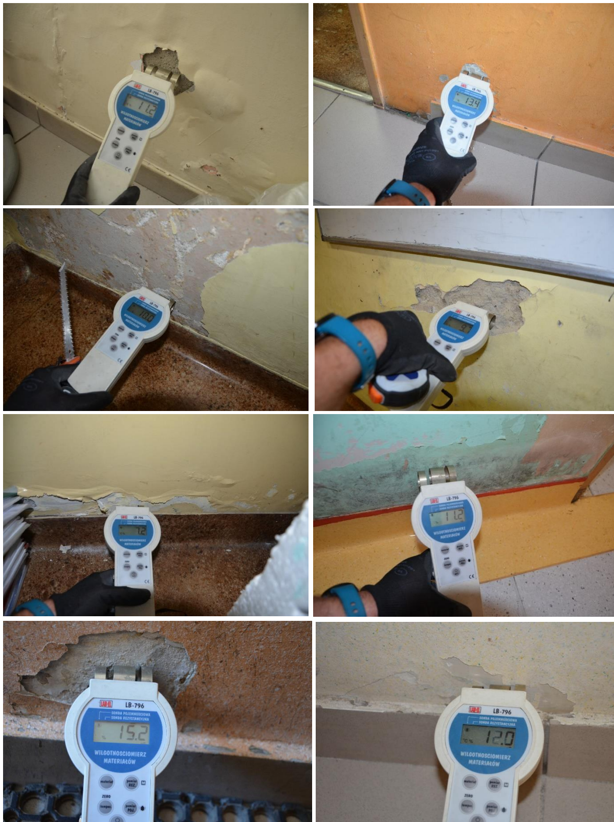
Fot. 54-61. Przykładowe pomiary zawilgocenia metodą pojemnościową w budynku nr 25.
