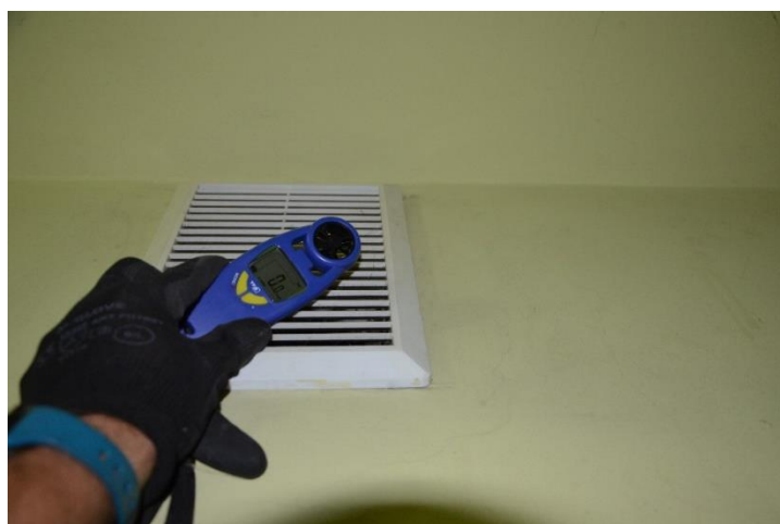
Fot.66. Przykładowy pomiar prędkości przepływu powietrza – 0m/s.
