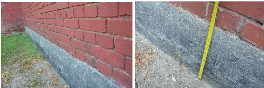
Fot. 42,43. Ogólny widok izolacji pionowej ścian budynku.
