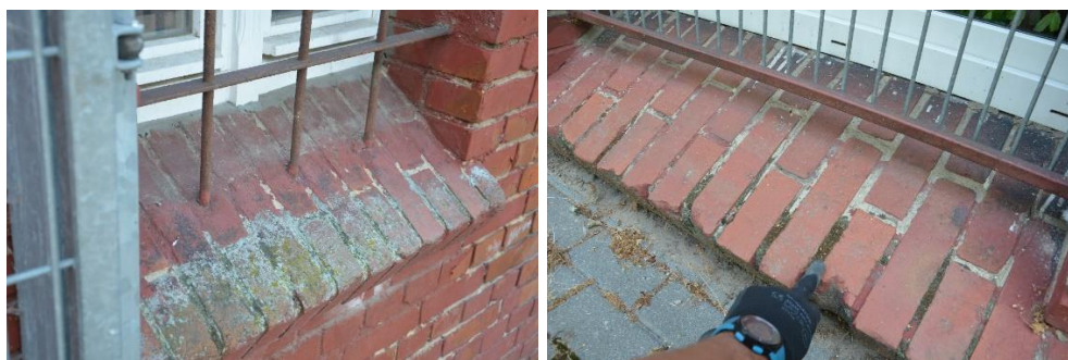
Fot. 23,24. Ogólny widok murowych parapetów zewnętrznych.
