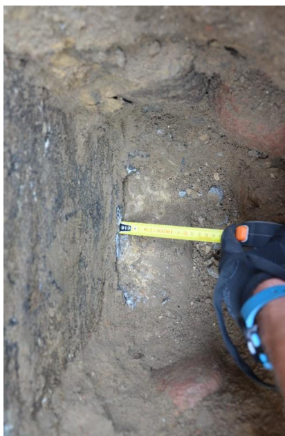
Fot.46. Odkrywka ściany zewnętrznej – widok odsadzki fundamentu.
