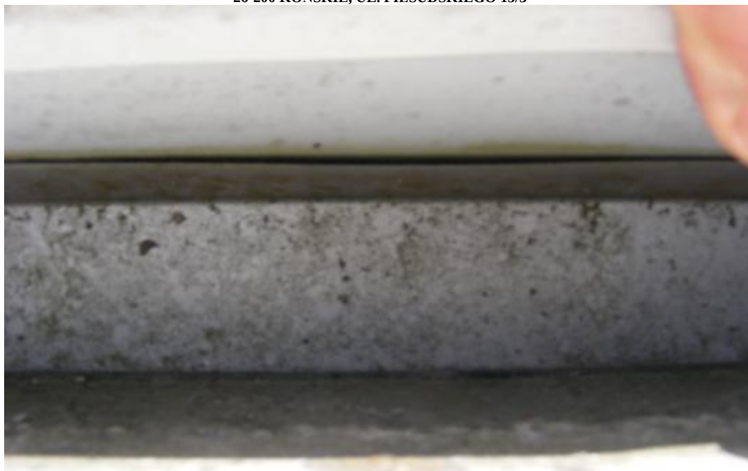
Fot. 2 Element stalowy w kalenicy – widok pod obróbką kalenicową
