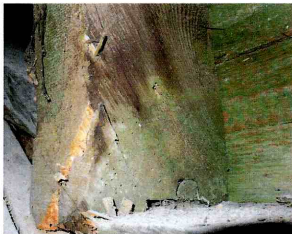
Fot. 4. Ślady żerowania kołatków w belce ryglowej mansardy.
